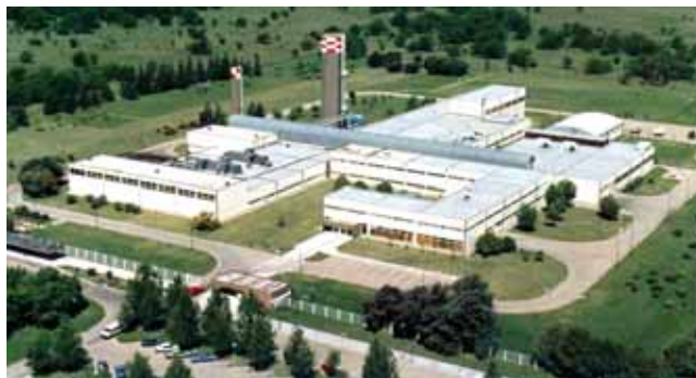
Planta industrial de CONUAR S.A. - Centro Atómico Ezeiza
